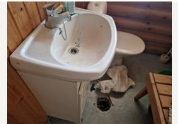
Wc-saunan pukuhuoneen lattiakaivo
