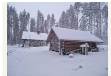
pää- ja varastorakennus koillisesta
