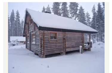
pää- ja varastorakennus lounaasta
